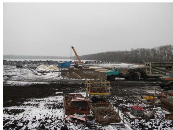
Przygotowania do odwiertu M-21
