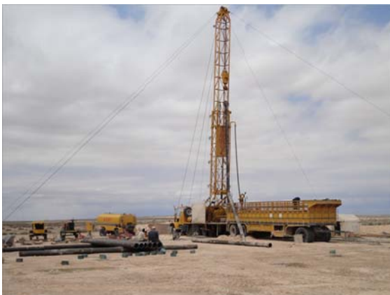
odwiert wodny na potrzeby odwiertu Itheria-1
