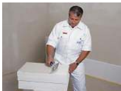
Rozprowadzenie zaprawy pacą zębatą
