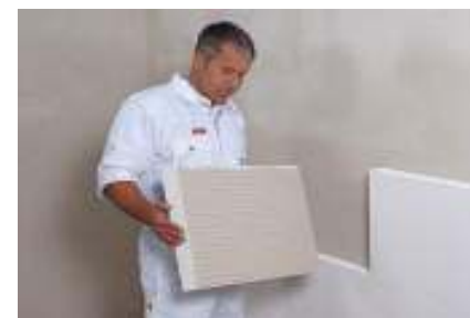
Grubość zaprawy – 8 mm
