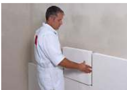
Przyklejenie płyty do ściany
